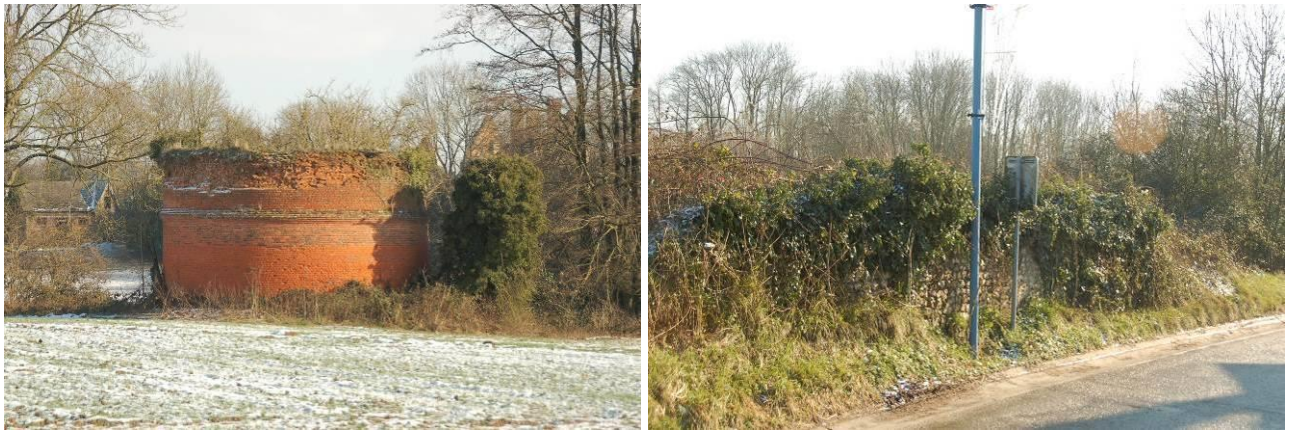
Illustrations 116 et 117 : Vestige d'un colombier et d'un ancien mur
