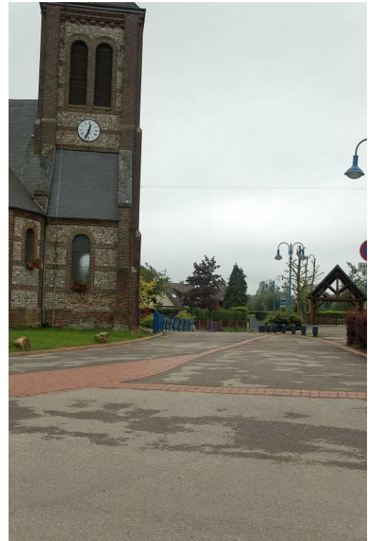
Illustration 67 : Aménagement urbain autour du centre bourg
